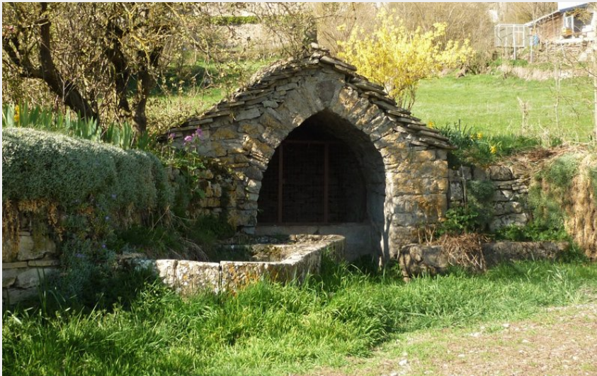
Fontaine voûtée à Novis (OT Causse Aubrac)
